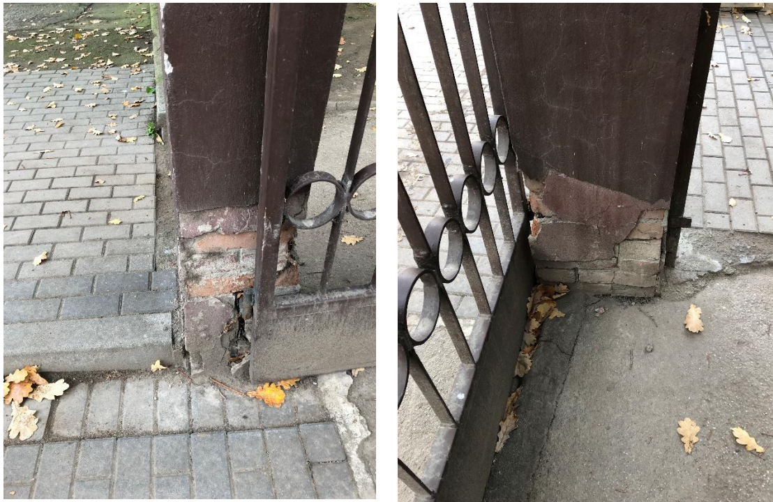
Fot. 11. Słupy murowane – uszkodzone partie przyziemia.
