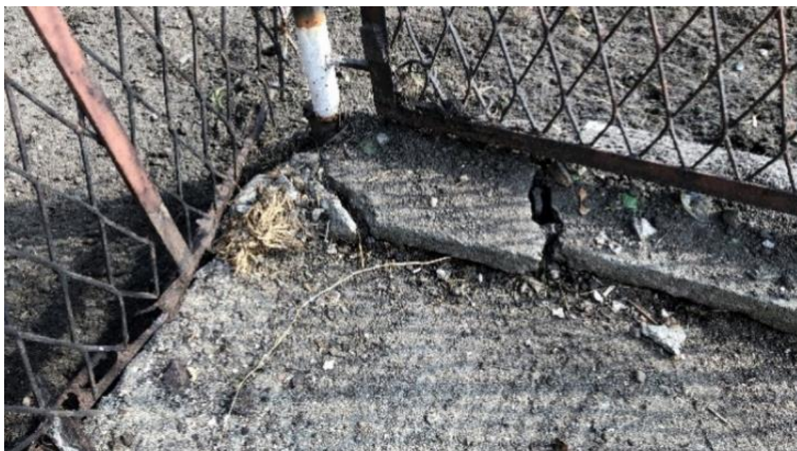
Fot. 6. Fragment cokołu ogrodzenia, południowo-zachodna granica skweru, z całkowitą degradacją struktury betonu.
